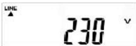
Fig. 7-4 – 12 Affichage R – Tension de sortie de l'onduleur photovoltaïque
